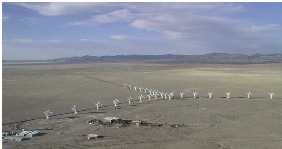
Σχήμα 2.9. Το ραδιοσυμβολόμετρο VLA (Very Large Array) στο New Mexico των Η.Π.Α. Αποτελείται από 27 παραβολικές κεραίες διαμέτρου 25 m που δύνανται να κινούνται πάνω σε ράγες διατεταγμένες σε σχήμα Y.
